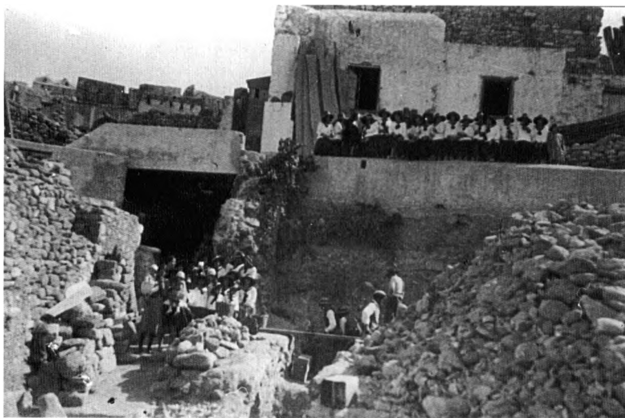
Εικ. 8. Φάση κατεδάφισης των εννέα κατοικιών (φωτ. του 1929-1930).
