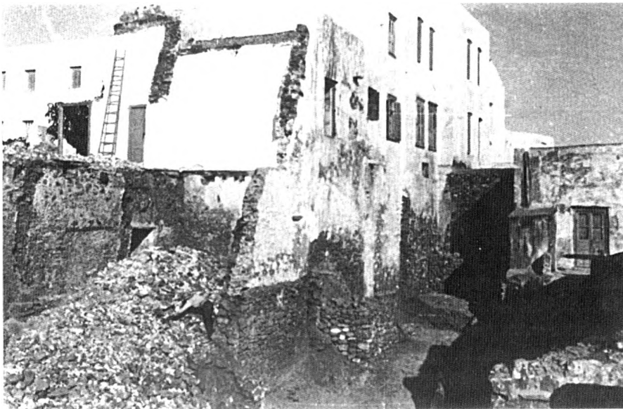
Εικ. 7. Φάση κατεδάφισης των δέκα κατοικιών (φωτ. του 1929-1930).
